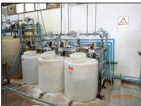
ภาพถ่ายที่ 2-35 ถังเติมคลอรีนฆ่าเชื้อโรค
